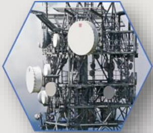
MONTAJE DE ANTENAS Y MICROONDAS
